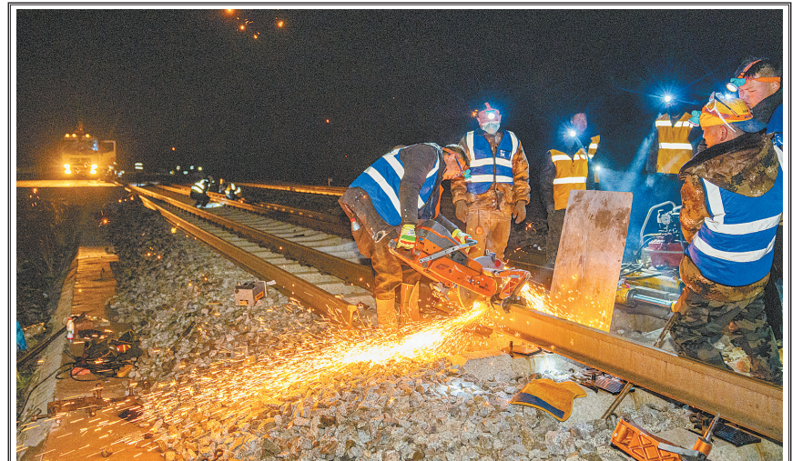
西藏安多 抢抓施工窗口期 升级青藏铁路钢轨 近日,在海拔4000余米的西藏安多南站,中铁十二局集团铁路养护公司职工抢抓夜间施工窗口期,开展青藏铁路格尔木至拉萨段股道无缝化改造作业。 新华社记者 丁增尼达 摄
