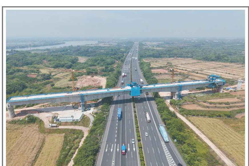
衢丽铁路衢江特大桥跨沪昆高速连续梁合龙
