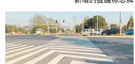
新增完善的路面标线
