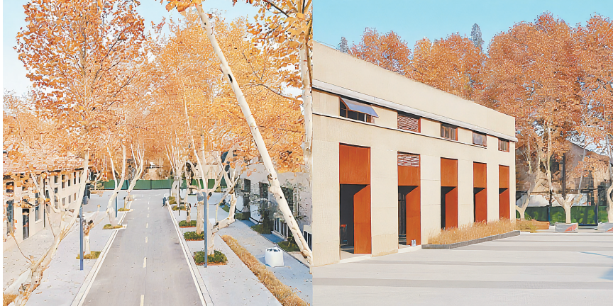
永拖61工社现场
