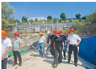
走访项目工地
