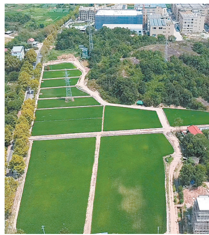
花街镇小界岭村片区耕地综合整治项目
