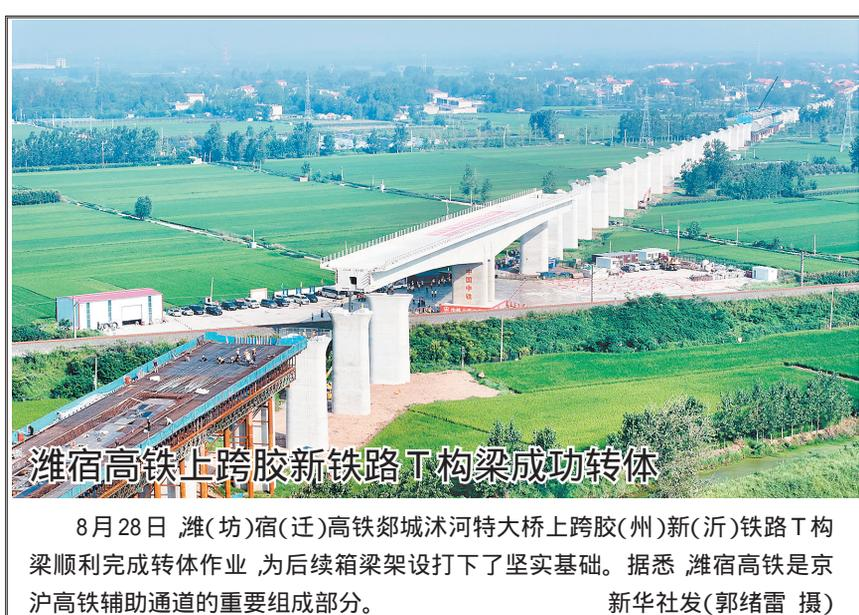
8月28日,潍(坊)宿(迁)高铁郯城沭河特大桥上跨胶(州)新(沂)铁路T构梁顺利完成转体作业,为后续箱梁架设打下了坚实基础。据悉,潍宿高铁是京沪高铁辅助通道的重要组成部分。 新华社发(郭绪雷 摄)
