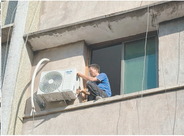
师傅在安装空调
