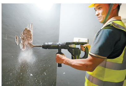
装修人员在施工
