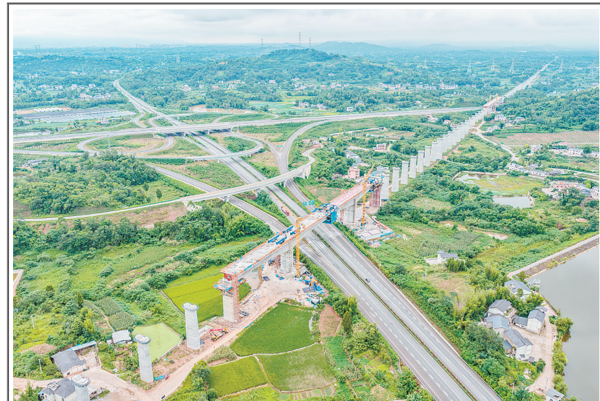
成渝中线高铁重庆段最大跨度连续梁合龙 7月8日,由中铁五局承建的成渝中线高铁土桥枢纽互通双线特大桥连续梁顺利合龙,该连续梁全长约242米,是成渝中线高铁重庆段跨度最大的连续梁。 新华社记者 唐奕 摄
