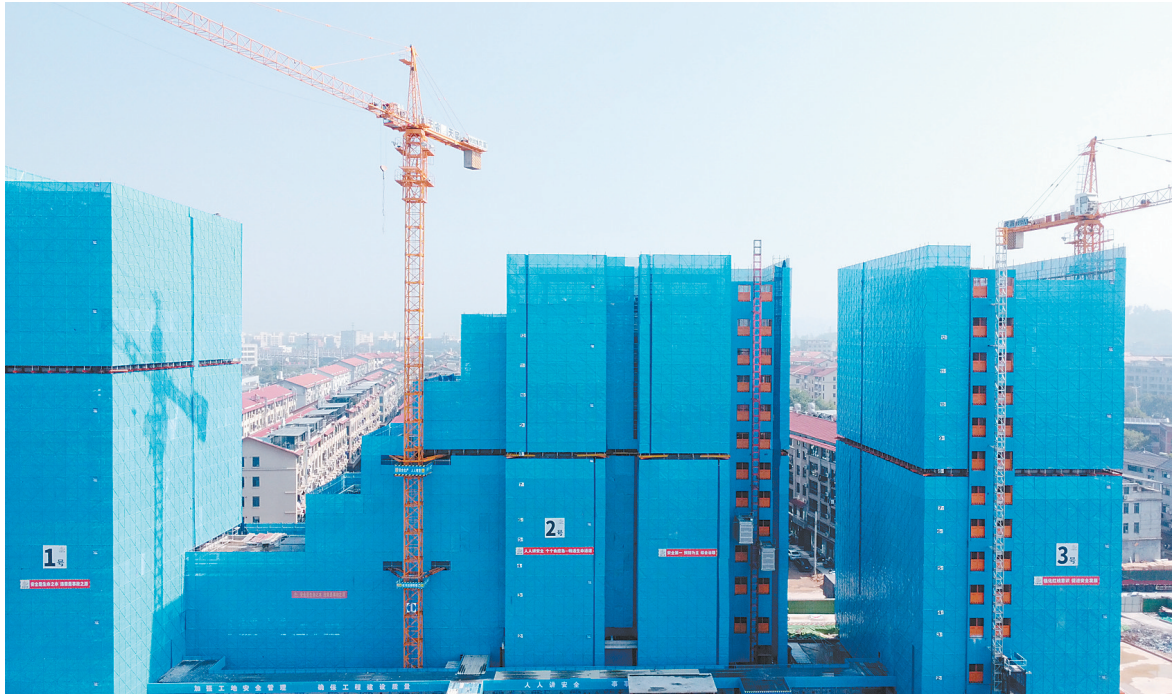
保障性租赁住房建设现场
