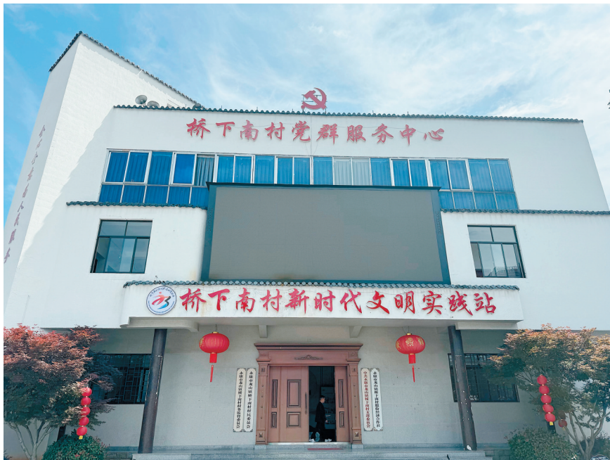
桥下南村新时代文明实践站
