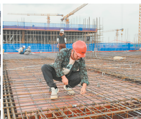
中兴产业园建设项目施工现场
