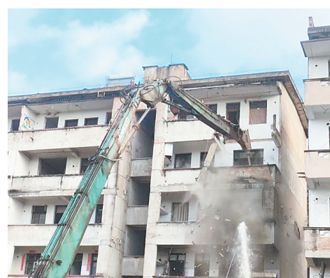
周塘区块旧城改建项目施工现场
