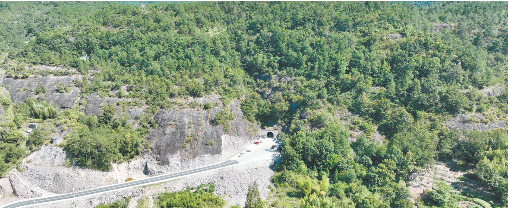
古山镇后塘弄二村横沿山隧道
