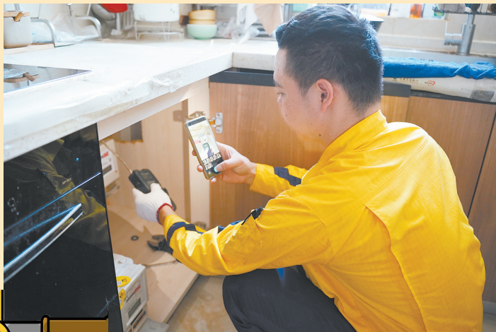
施工人员为用户安装新燃气表
