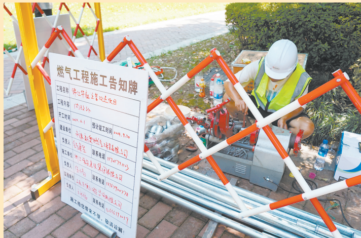
锦江华庭小区燃气管道施工现场
