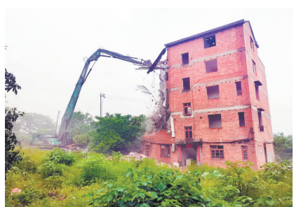
永武产业飞地科创中心地块旧房拆除
