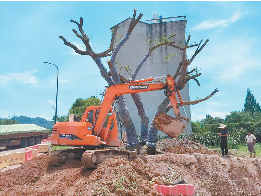
古树 搬家 现场
