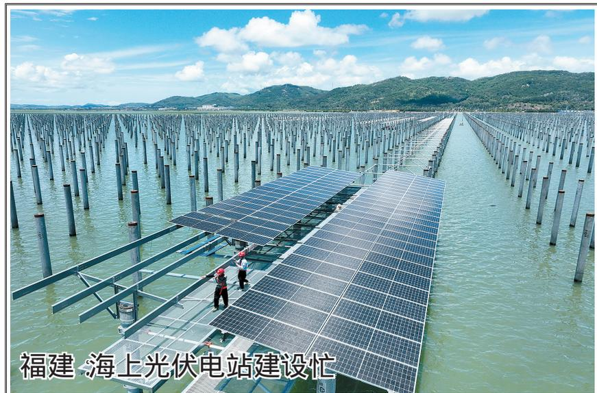
福建 海上光伏电站建设忙 6月20日,施工人员在海上光伏电站现场安装支架和光伏组件(无人机照片)。三峡集团东山杏陈180MW海上光伏电站位于福建省东山县杏陈镇、前楼镇海域,这里日照长、风速大,属于抗台型潮汐带海上光伏项目。该项目采用上部光伏发电与下部海域渔业养殖相结合的模式,实现海域立体综合开发。据介绍,该项目今年2月开工,建成后每年平均可提供清洁电能3亿千瓦时,可节约标准煤9.02万吨。 新华社记者 林善传 摄
