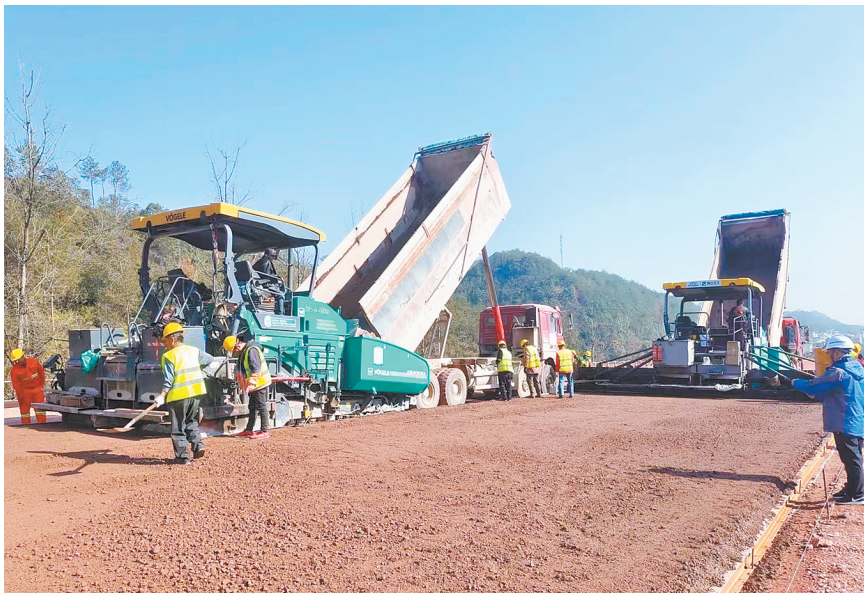
S316项目施工现场
