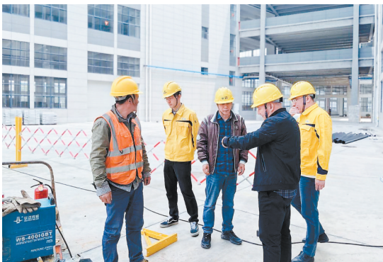
检查管道燃气在建工程
