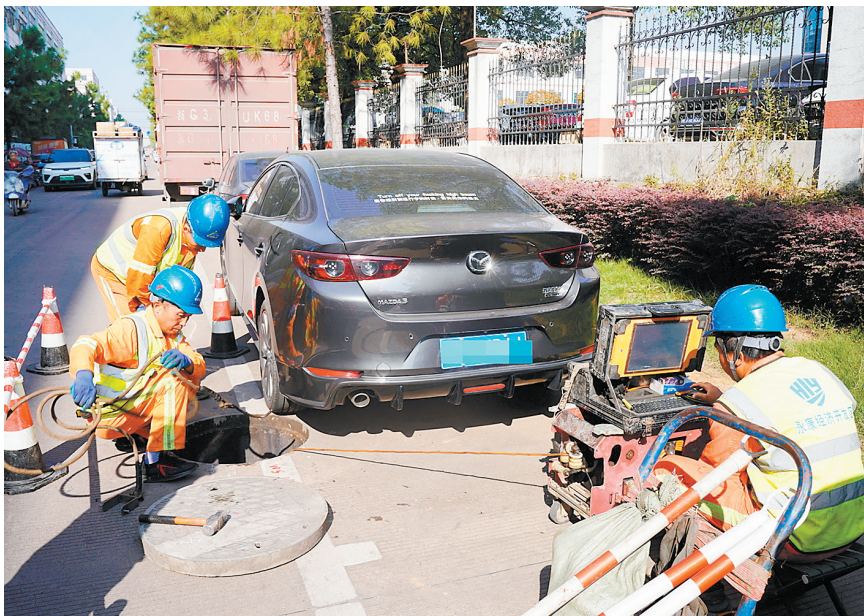
工作人员检测污水管道
