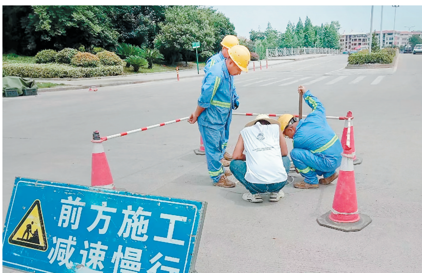
检查人员检查排水口
