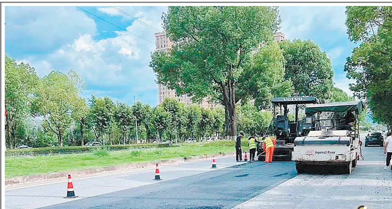
五金大道路面 整体改造工程完工
