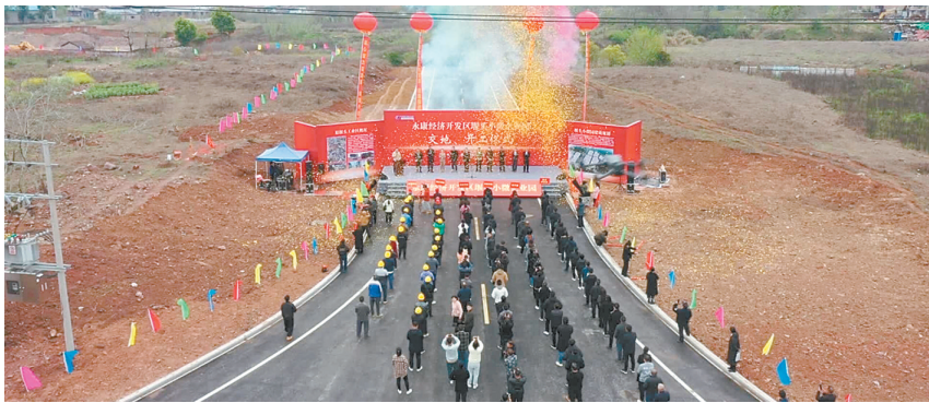
堰头小微企业园开工
