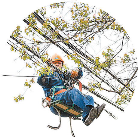
高空作业的电线维修员
