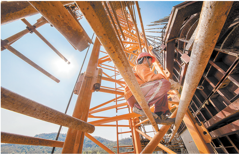
高架上的建筑工人
