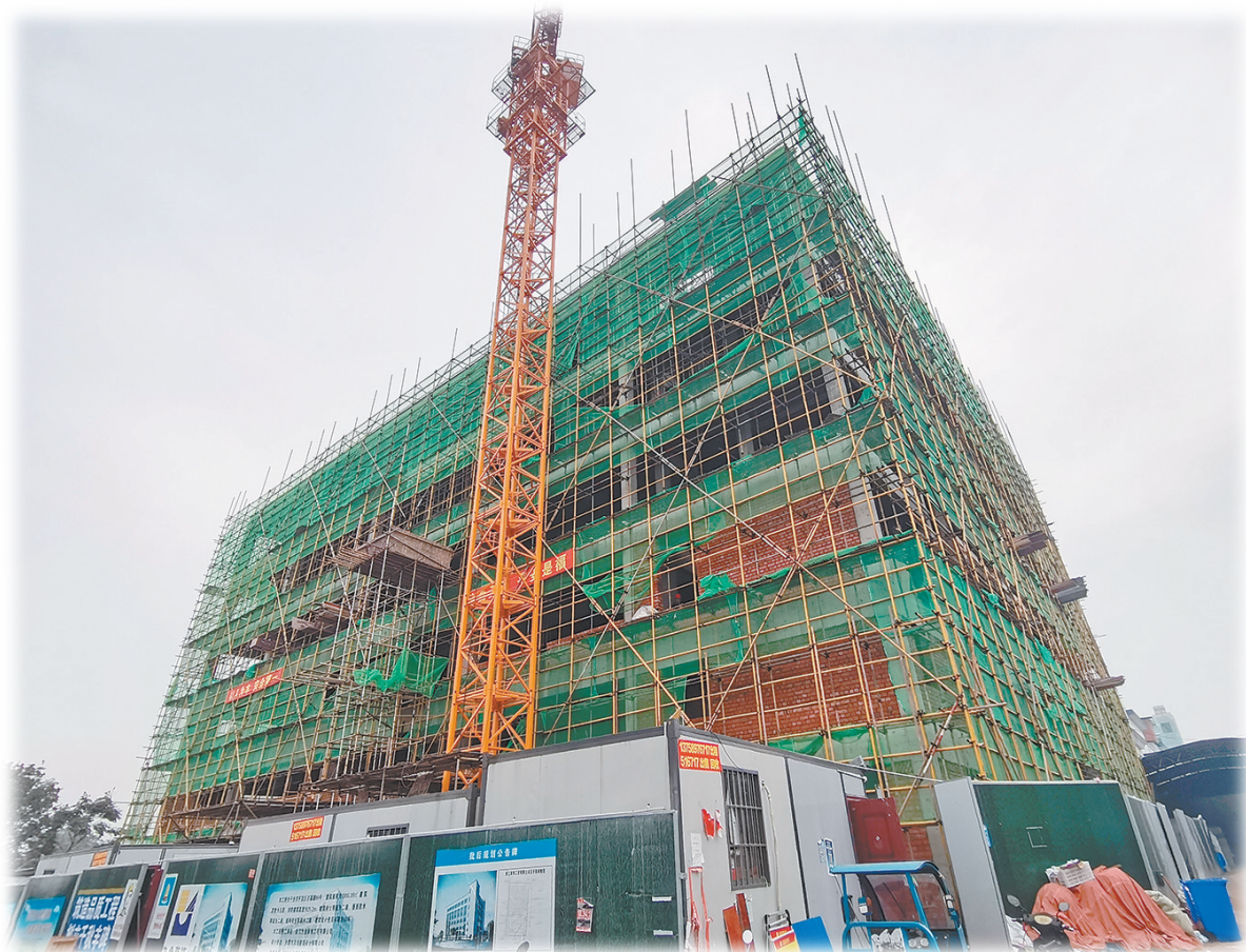
双伟公司在建厂房
