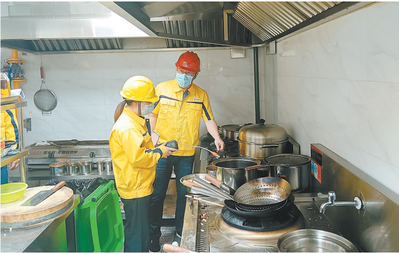
相关人员检查商铺燃气管道
