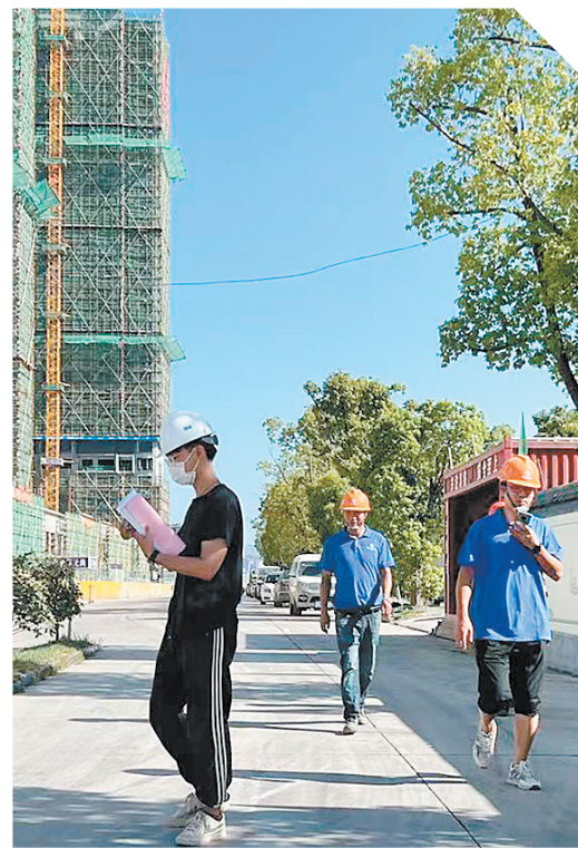
巡查在建工程
