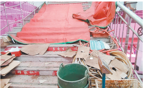
华丰菜场某处楼梯间堆满货物 融媒记者 胡锦
