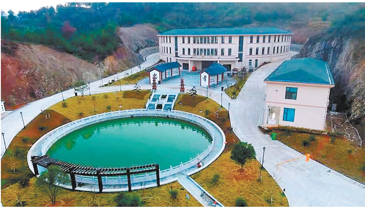
永安居骨灰堂(省级首批节地生态安葬示范点)
