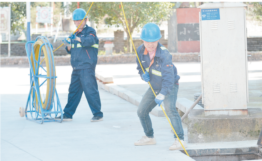
光纤宽带安装施工现场
