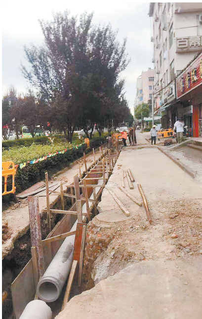
“污水零直排区”建设现场
