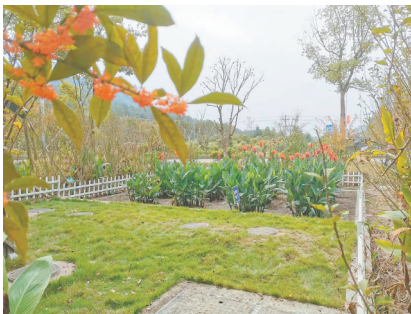
排水公司运维的农村生活污水处理终端
