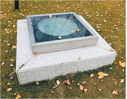
地面看到的导光管外貌。
