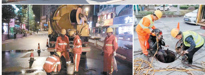
排查整治现场
