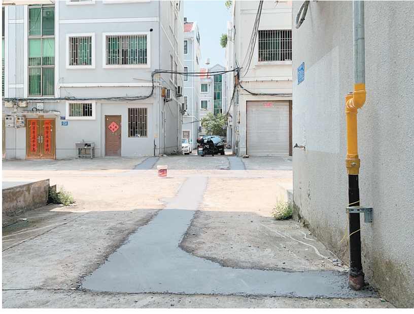
小区内开挖的路面已回填
