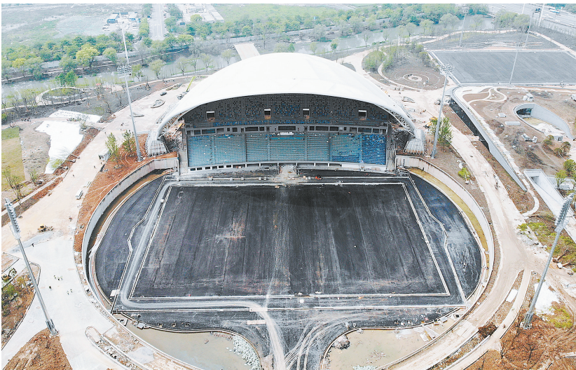
建设中的杭州亚运会曲棍球场馆。9月10日晚,杭州亚运会倒计时一周主题活动将在杭州奥体中心网球中心举行,杭州亚运会官方体育服饰、礼仪服装和火炬即将揭晓,主会场将与海内外亚运城市互动连线。
