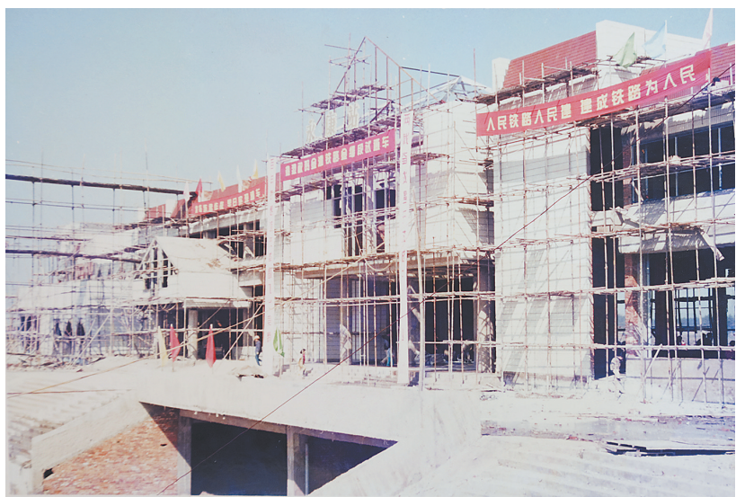
1995年3月,建设中的永康站
