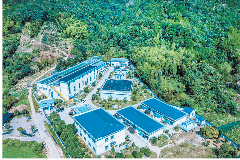
珠坑水厂厂区。
