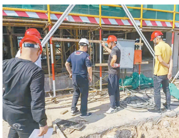
检查工地建设
