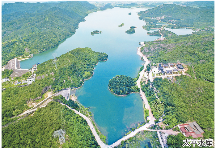
太平水库主坝位于龙山镇凤凰山脚 ,集雨面积 37.88 平方千米 ,引水面积 45 平方千米。水库总库容 4173 万立方米 ,养鱼面积 3977 亩 ,库口建电站 1 座。
