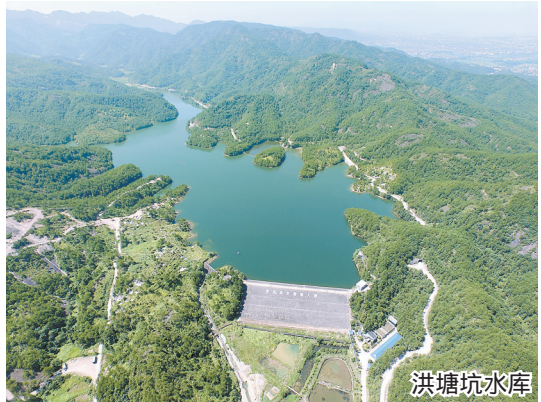
洪塘坑水库位于西溪镇西溪村南 ,集雨面积 7.64 平方千米 ,总库容 522.8 万立方米。水库灌溉西溪镇、龙山镇计 533.33 公顷农田。
