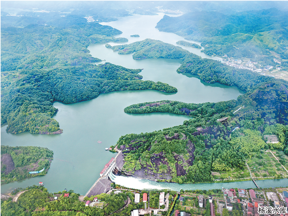
杨溪水库主坝位于石柱镇洪福村麻车口自然村 ,是市内最大的蓄水工程。水库集雨面积 124 平方千米 ,总库容 6453 万立方米 ,是一座以灌溉为主 ,结合防洪、供水、发电等综合利用的中型水库 ,灌溉石柱、芝英、象珠等镇的 191 个行政村。
