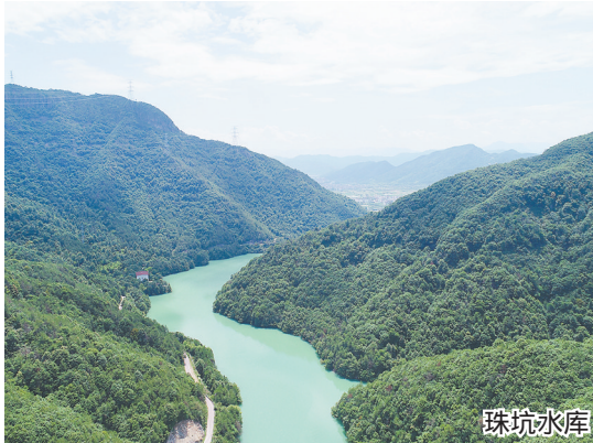
珠坑水库位于前仓镇大陈村 ,集雨面积 10.50 平方千米 ,总库容 343 万立方米。该水库的水碧蓝清澈 ,水质达到国家一类标准。
