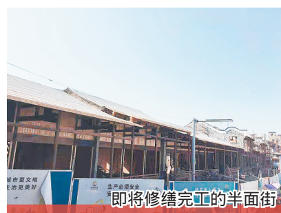
即将修缮完工的半面街
