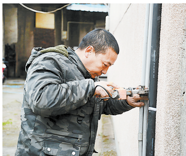
施加兴在维修水管
