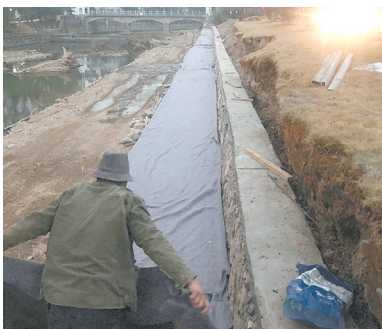
工作人员对新浇筑混凝土铺盖毛毡
