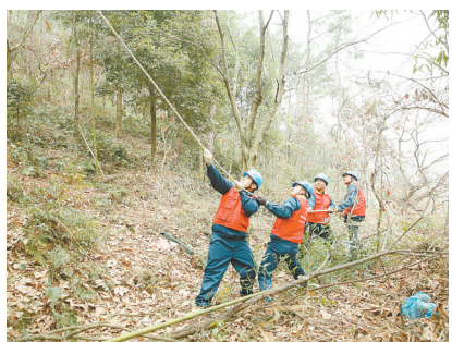
电力工人清理影响高压线的竹子
