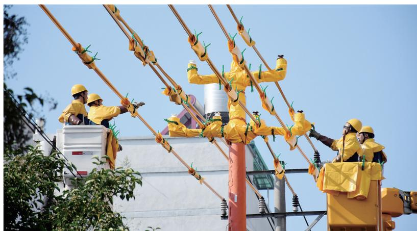
双回三角排列线路在双回路线路中具有一定占比,仅金华就约有30%。为攻克此类线路带电作业难题,今年4月起,市供电公司成立技术攻关团队,自主研发省内首套双回三角排列线路带电立撤杆工具。该工具由绝缘横杆、三角撑杆、横担遮蔽罩三物件构成,可以可靠固定导线,确保导线保持安全距离,消除作业过程中相间安全距离不足、相间导线容易误触等安全隐患,作业安全系数得以大大提升。
