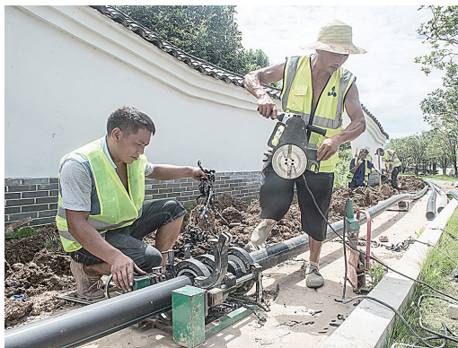
西溪镇水利工人抢修自来水管。
