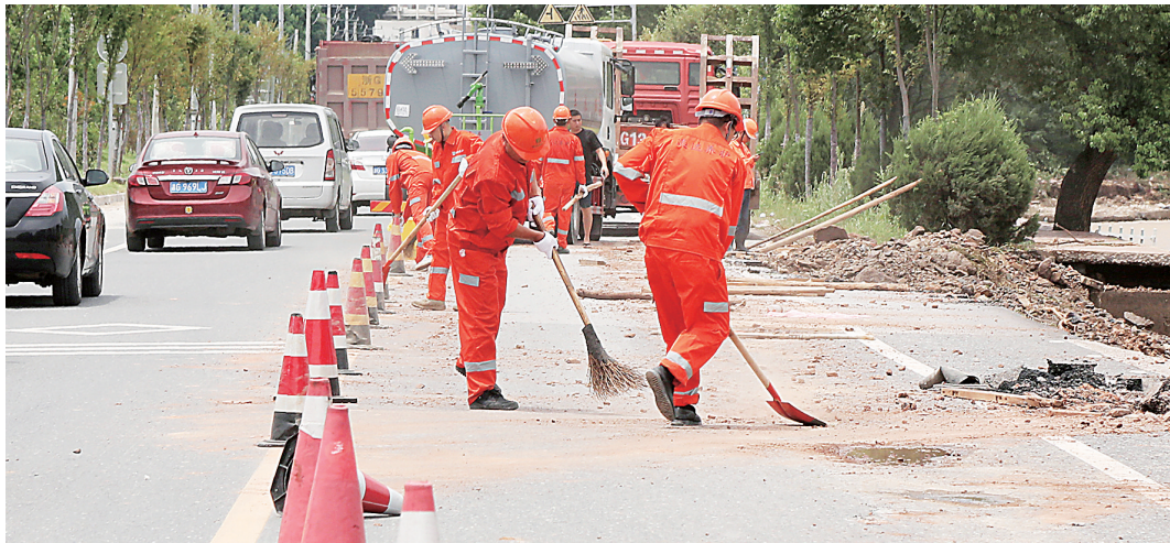
养护工人清理道路淤泥。
