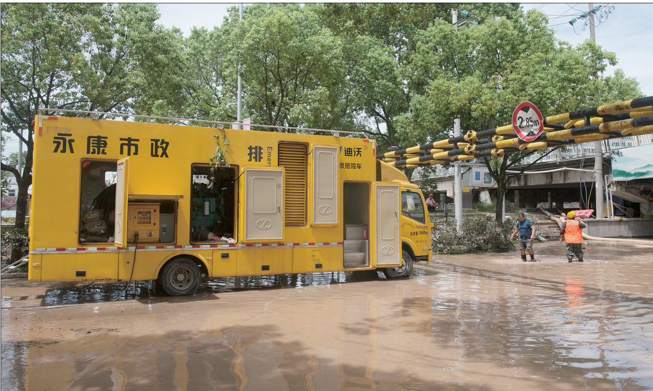
台风“黑格比”带来的强降水造成城区部分路段被淹,水退去后留下大量淤泥和垃圾。8月5日,有关部门对道路进行清淤和排水,为市民营造干净整洁的出行环境。 记者 杨成栋 摄
