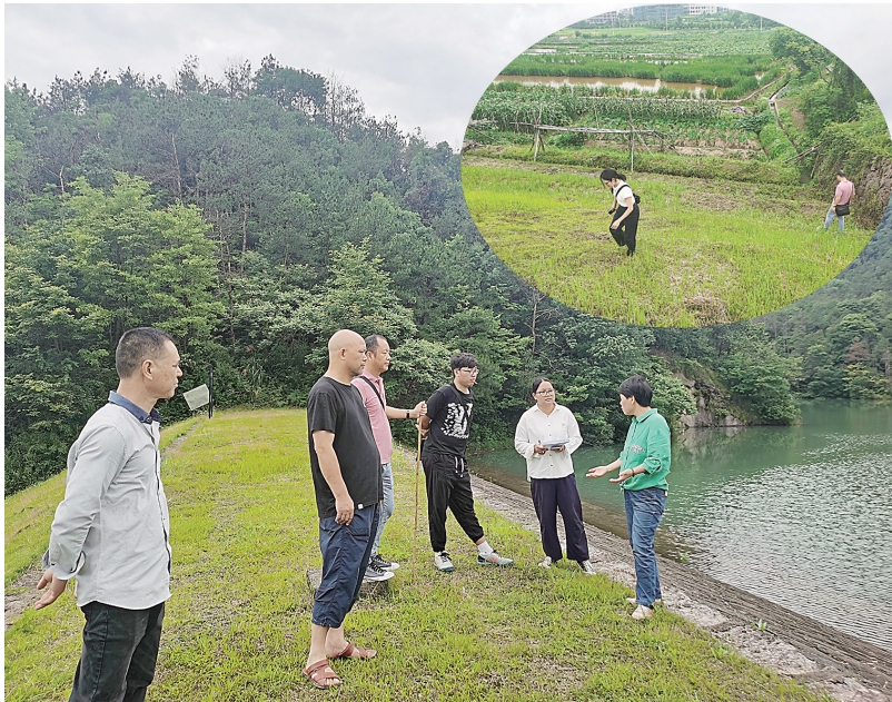
检查组汇总大坝整体情况、存在问题 现场检查人员正用脚踩排查坝坡
