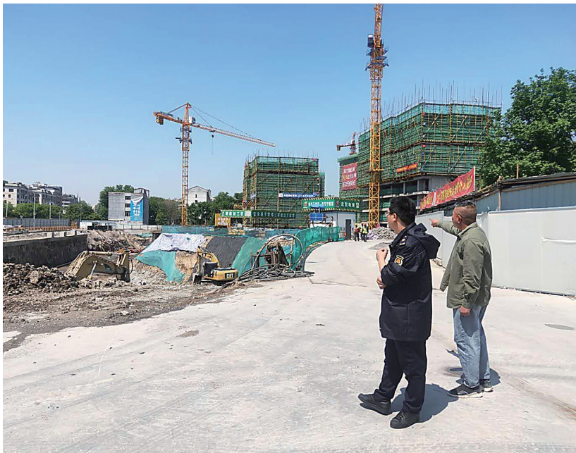
执法人员在施工现场检查
