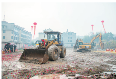
大园东村西坑自然村农民公寓开工
