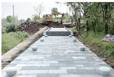
晏塘村美丽乡村建设工程进行中
