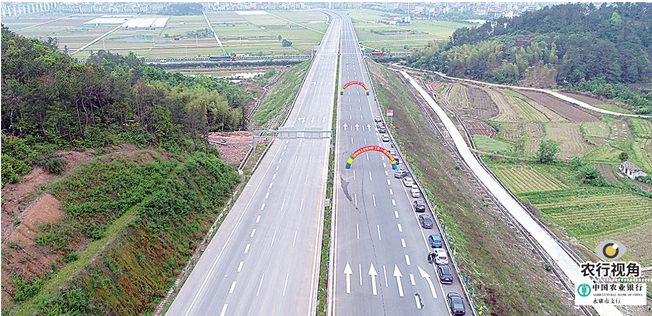
330国道永康段改建工程(一期)主线通车 记者 杨成栋 摄
